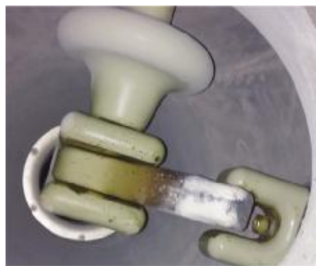
图5 动触头与线路接地开关静触头发生偏离
